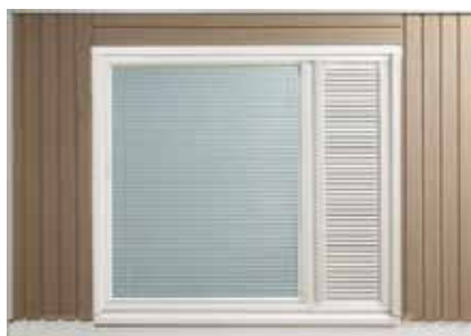
Sälekaihtimet ja tuuletusluukku.
